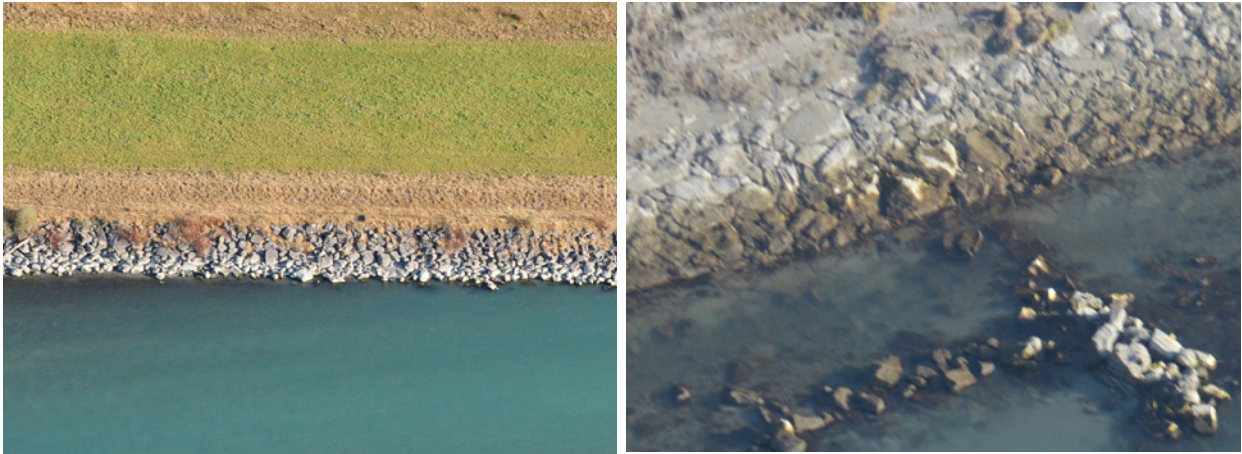
Abb. 9: Unterschiedliche Verbauungstypen am Alpenrhein: links Blockwurf auf Höhe Illmündung; rechts: verfugter Blocksatz (Steinschichtung) und Bühne unterhalb von Lustenau.
